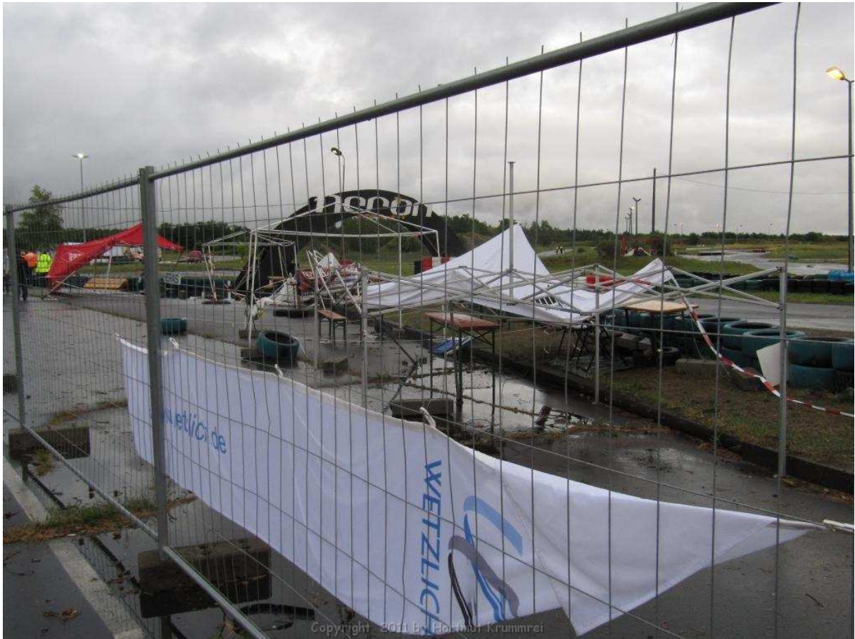
Geländeverwüstung nach Sturm
